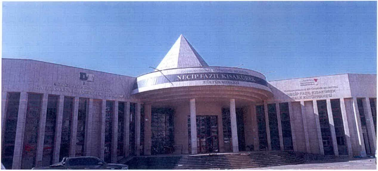
Resim-1: Yıkımı Yapılacak Olan Bina.
