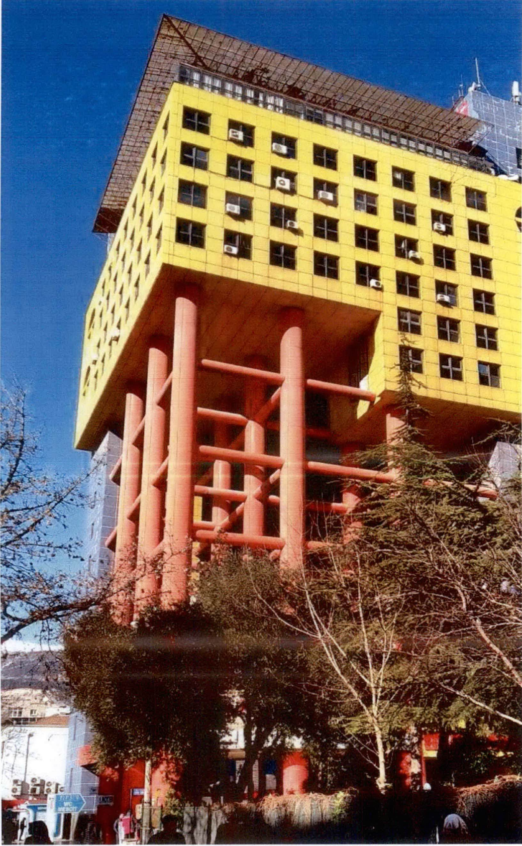
Resim-1: Yıkımı Yapılacak Olan Bina.
