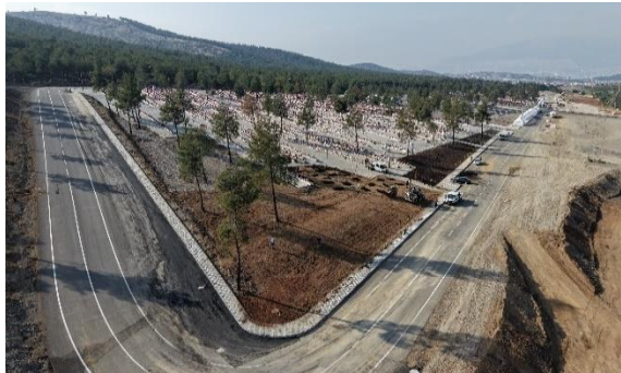
Kapıçam Mezarlığı Çevre Düzenlemesi
