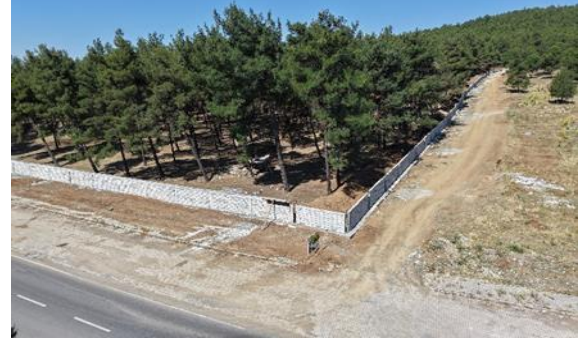
Hayvan Barınağı Duvar Çalışması
