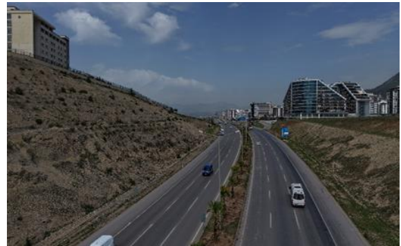
Önsen Yolu Refüj ve Kavşak Düzenleme Çalışması
