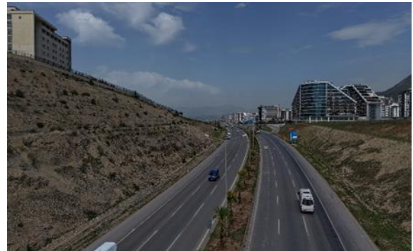
Önsen Yolu Refüj ve Kavşak Düzenleme Çalışması
