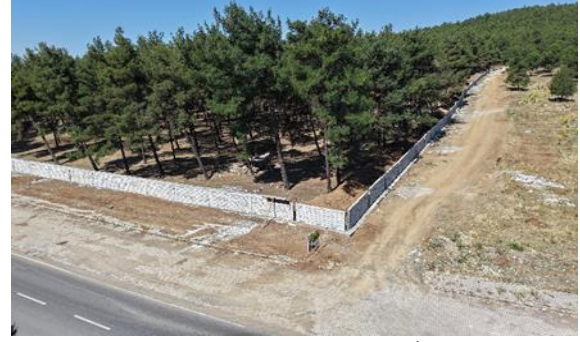
Hayvan Barınağı Duvar Çalışması
