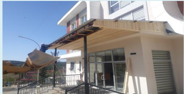
Millet Konağı Sundurma ve Lambiri Yapımı
