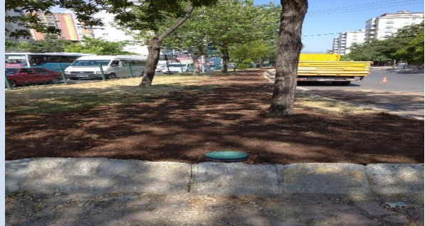
Süleyman Paşa Bulvarı Refüj Düzenleme Çalışması
