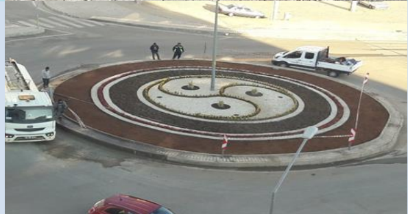
Ahırdağ Caddesi Refüj ve Kavşak Düzenleme Çalışması
