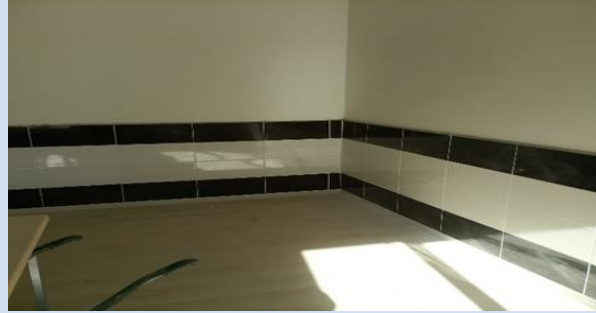
Mehmet Arıkan Taziye Evi Bakım ve Onarım Çalışması
