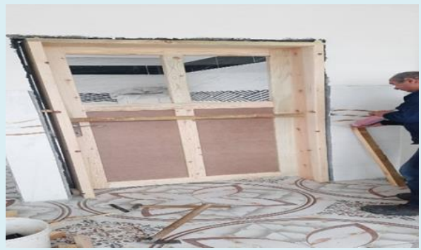
Yahya Kemal Mahallesi Fakir Evi Kapı Yapım Çalışması
