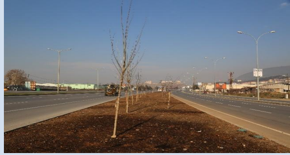
Kayseri Yolu Boğaziçi Mevkii Yeşil Alan Çalışması
