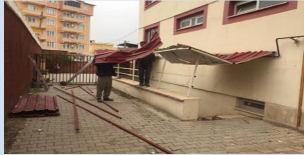
Dulkadiroğlu İlçesi Bayazıtlı Mahallesi Sultan Bayazıt İlkokulu Bakım ve Onarım Çalışması
