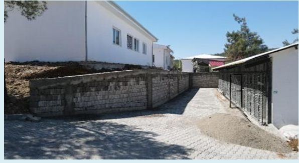
Hayvan Barınağı Çevre Düzenleme Çalışması
