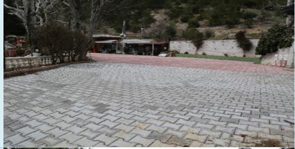
Çınaraltı Restoran Bakım ve Onarım Çalışması
