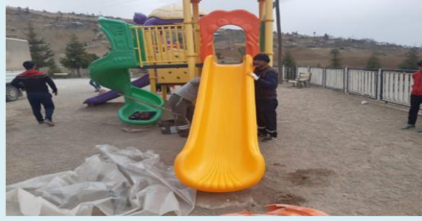
Dulkadiroğlu İlçesi Baydemirli Mahallesi Oyun Grubu Bakım ve Onarım Çalışması
