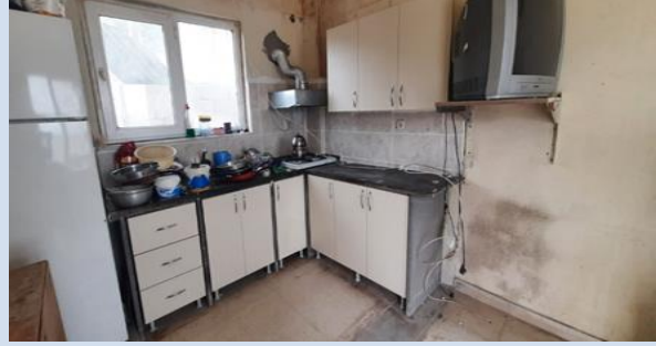
Kum Ocağı Mutfak Dolabı Montaj Çalışması
