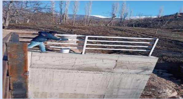
Peynirdere Mahallesi Köprü Korkuluğu Montaj Çalışması
