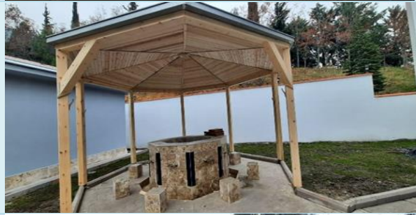
İl Jandarma Komutanlığı OSB Kaplama Çalışması
