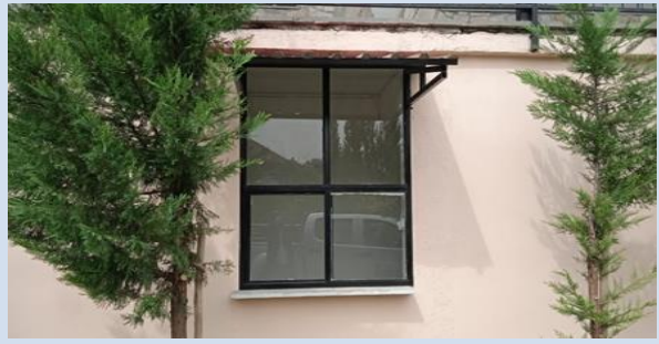
Millet Konağı Çay Ocağı Bakım ve Onarım Çalışması
