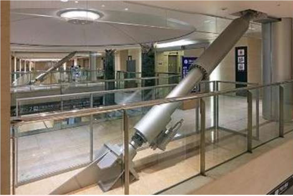
Tokyo Belediye Binasının Güçlendirilmesi
